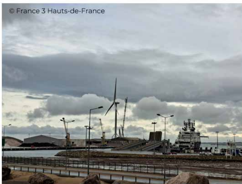
En France, la première éolienne géante est installée sur le port de Boulogne-sur-Mer
